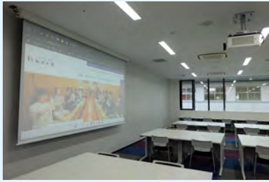
▲吊り下げ式のプロジェクターや天井埋め込みスピーカーを設置するなど、他のPC教場と同等のAV環境を構築
