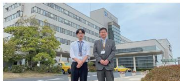
津山中央病院様 外観
